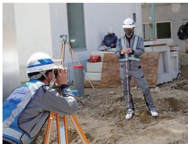
現場で活躍する若手社員(測量の様子)
