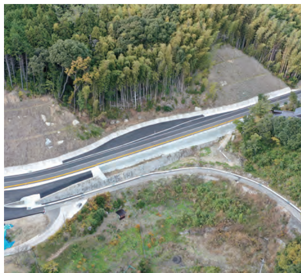
一般県道銭壺山公園線整備工事
