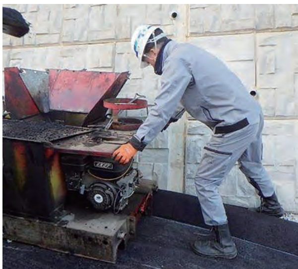
現場で活躍する若手社員（道路の仮舗装の様子）
