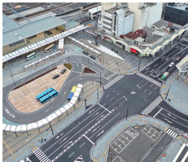
国道188号岩国駅前交差点舗装外工事
